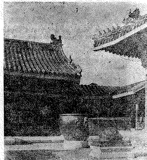
Coin de cour de la section Est des palais.
